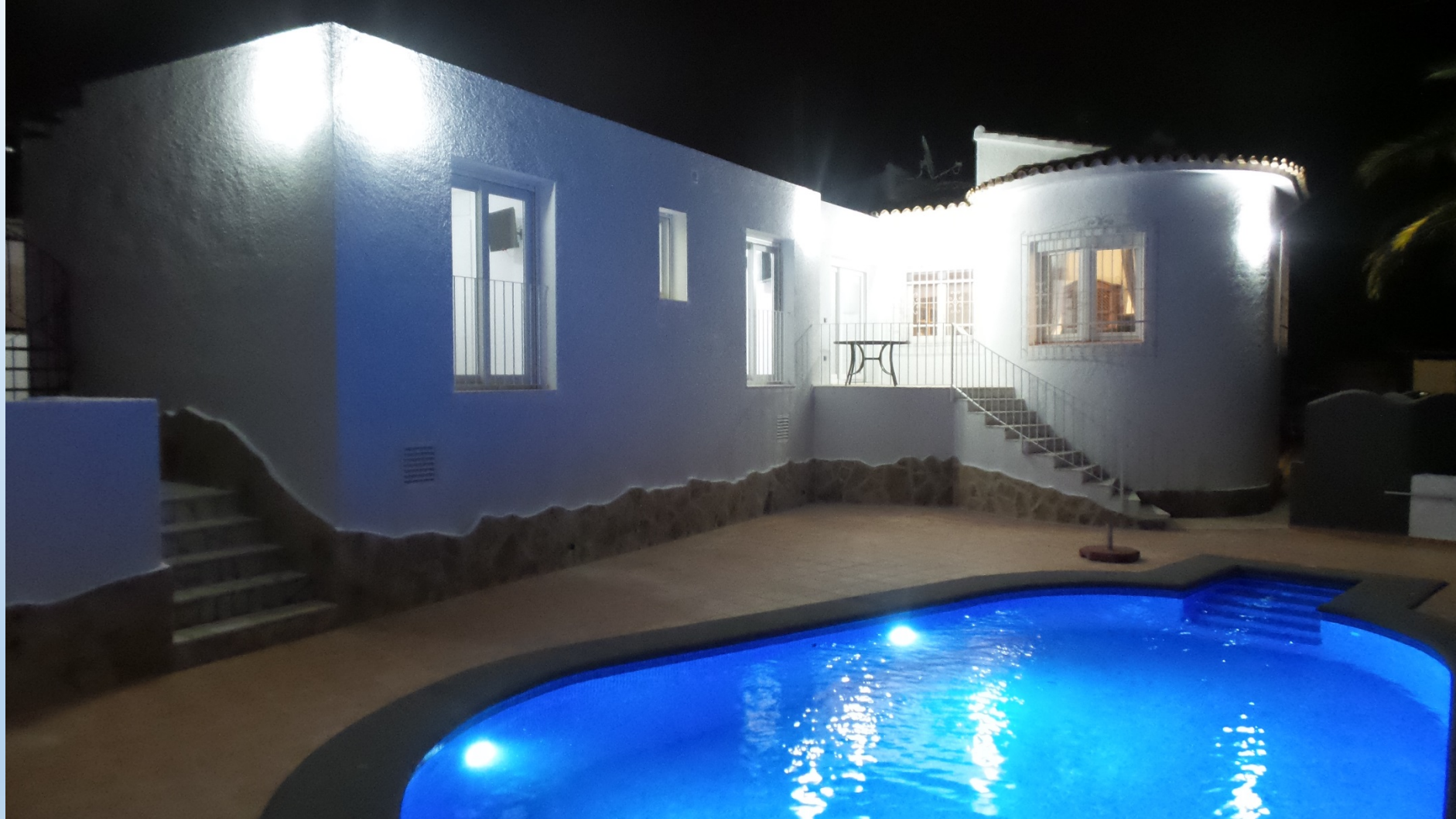
Ansicht: Vorderseite von Poolterrasse aus bei Nacht
